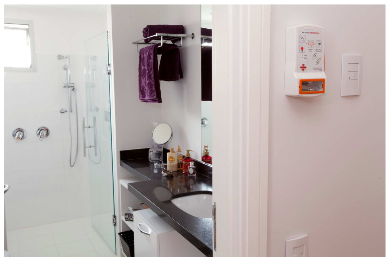
Central de alarme
