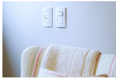
Comando de ventilador
